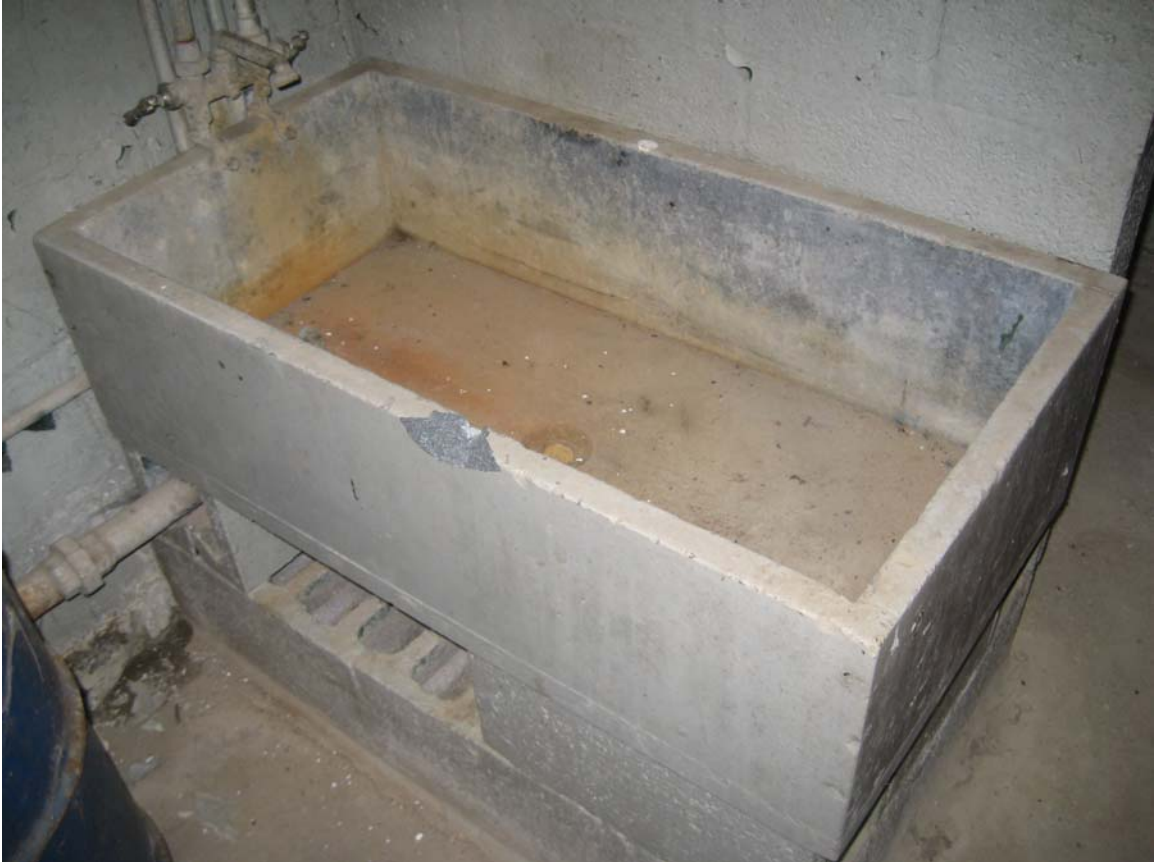
HA #5 – Non asbestos containing sink
